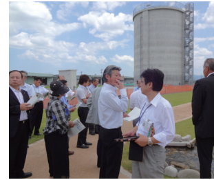
6月27日 春江北部水路調圧水槽見学
